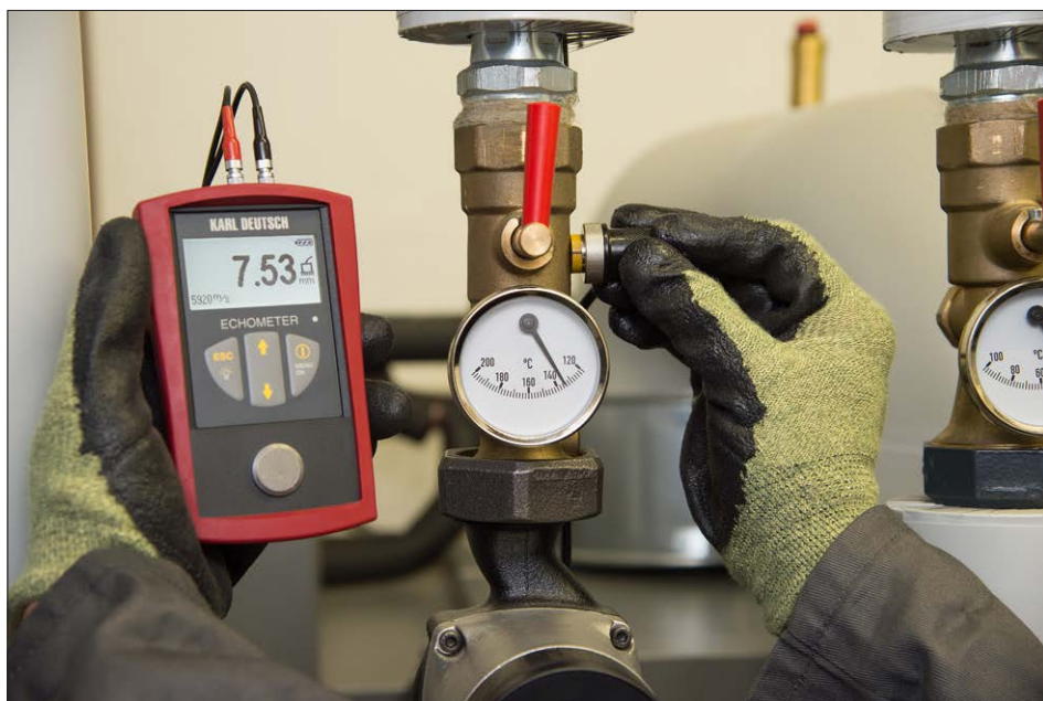
Wanddickenmessung an einer 135 °C heißen Oberfläche
