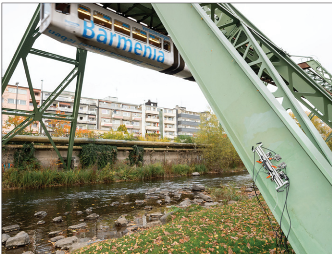
伍珀塔尔市悬挂列车的焊缝检测
